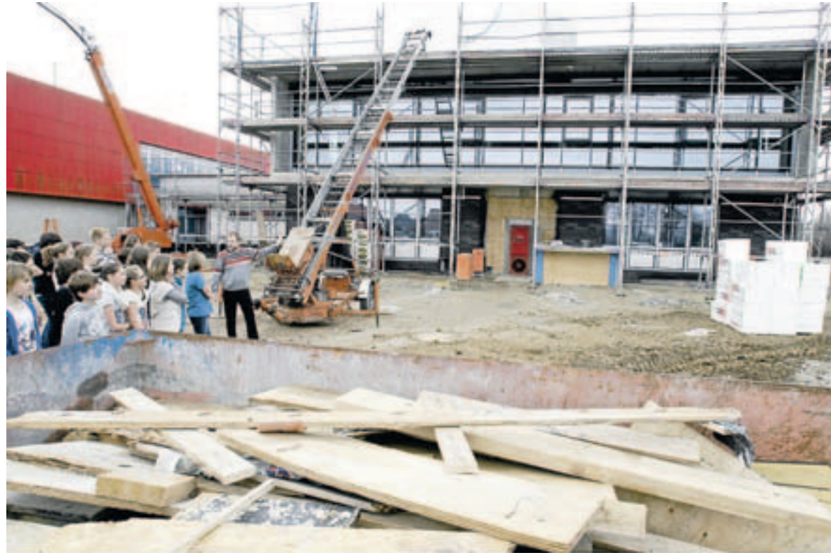
Schulleiter Jan-Peter Braun zeigt der Klasse 6 e die Baustelle der IGS Lengede. Wenn der Neubau fertig ist, soll im gesamten Schulkomplex ausreichend Platz für alle sein – inklusive einer dreizügigen gymnasialen Oberstufe. Foto: Bode
