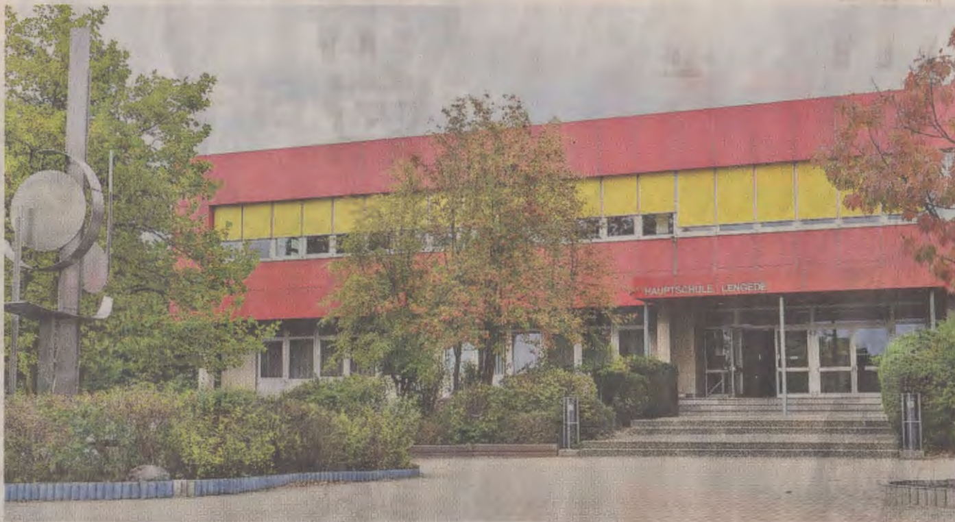
Standort der neuen Gesamtschule in Lengede: Das Hauptschulgebäude am Bodenstedter Weg.
