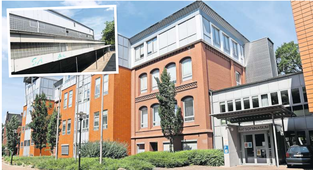
Ein Schwerpunkt der Sanierungsarbeiten ist das Peiner Ratsgymnasium – und dort vor allem die Sporthalle (kleines Foto).
