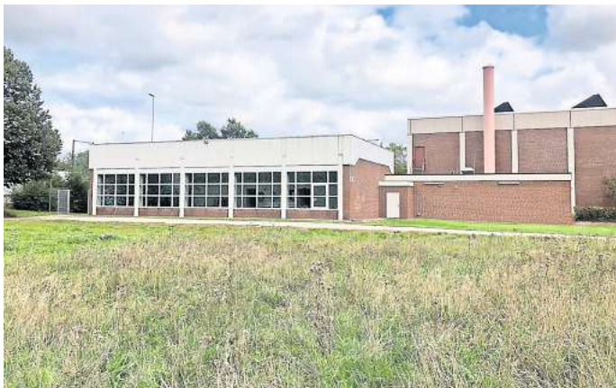
Auf der Freifläche vor dem Lehrschwimmbekken wird die neue Einfeldsporthalle mit Sanitär- und Umkleideräumen errichtet.
