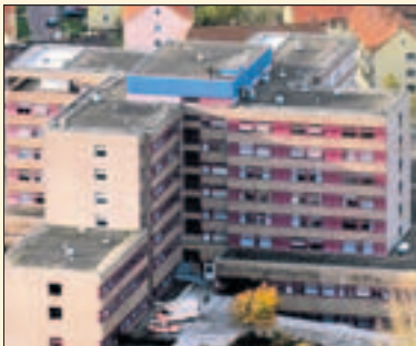
Helmstedt: Das Kreiskrankenhaus wird modernisiert.
